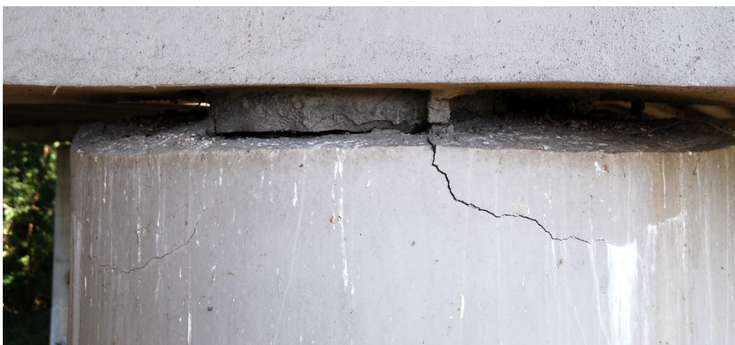
Obrázek 11 Trhliny pod ložiskem. Výška nad terénem cca 10 m.
