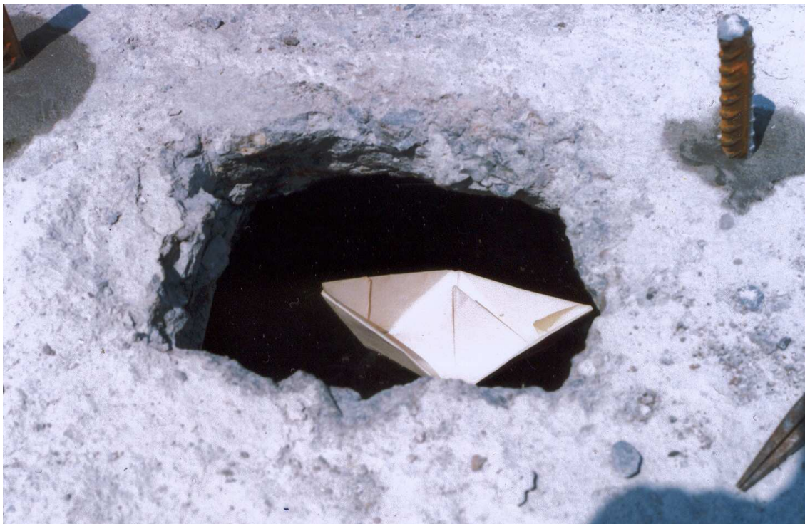
Obrázek 5 Složená papírová lodička plave na hladině totálně zaplavené dutiny nosníku KA.
