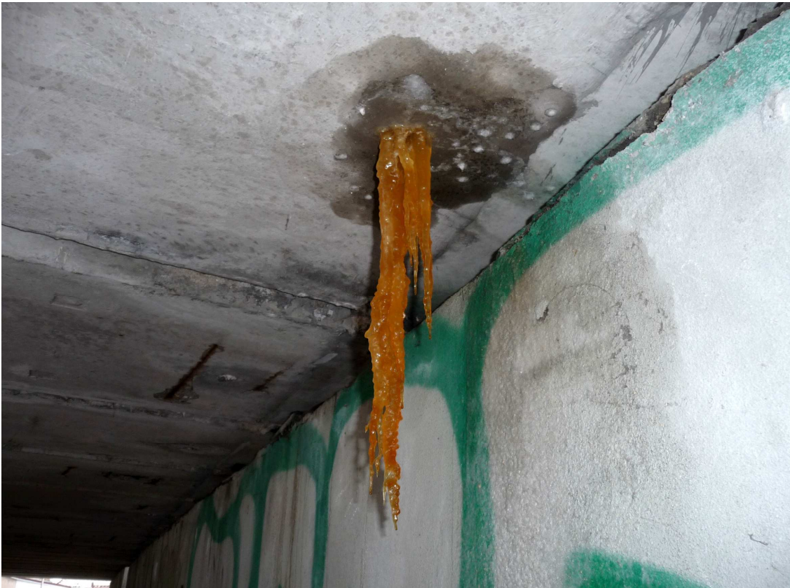
Obrázek 3 Skutečně nejde o dřáblův jazyk, to jenom mráz zastavil výtok z právě odvrtaného nosníku.
