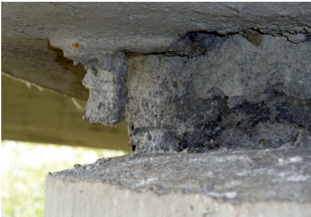
Obrázek 10 Sanované ložisko pod vrstvou torkretu.
