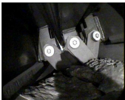
Obrázek 13 Při bližším pohledu vidíme, jak vyhřezlý beton ve skutečnosti znemožňuje správnou funkci dilatačního závěru.
