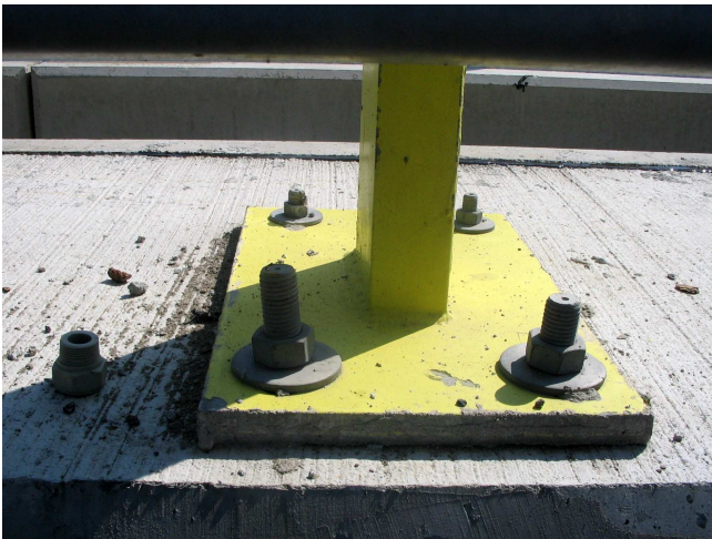
Obrázek 15 Drama se skrývá v detailech... kotvení zábradelních sloupků může vypadat takhle,
