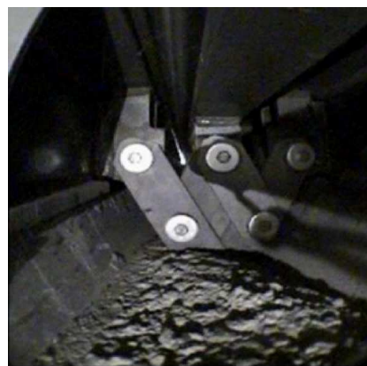
Obrázky 14 Snímky z minikamery, zasunuté do útrob dilatačního závěru 3W odhalují zajímavá tajemství – neodstraněné montážní tyče nebo zabetonovanou celou dilatační spáru. Svařený a zabetonovaný dilatační závěr byl na první pohled bez vady, až na to, že vůbec nefungoval...
