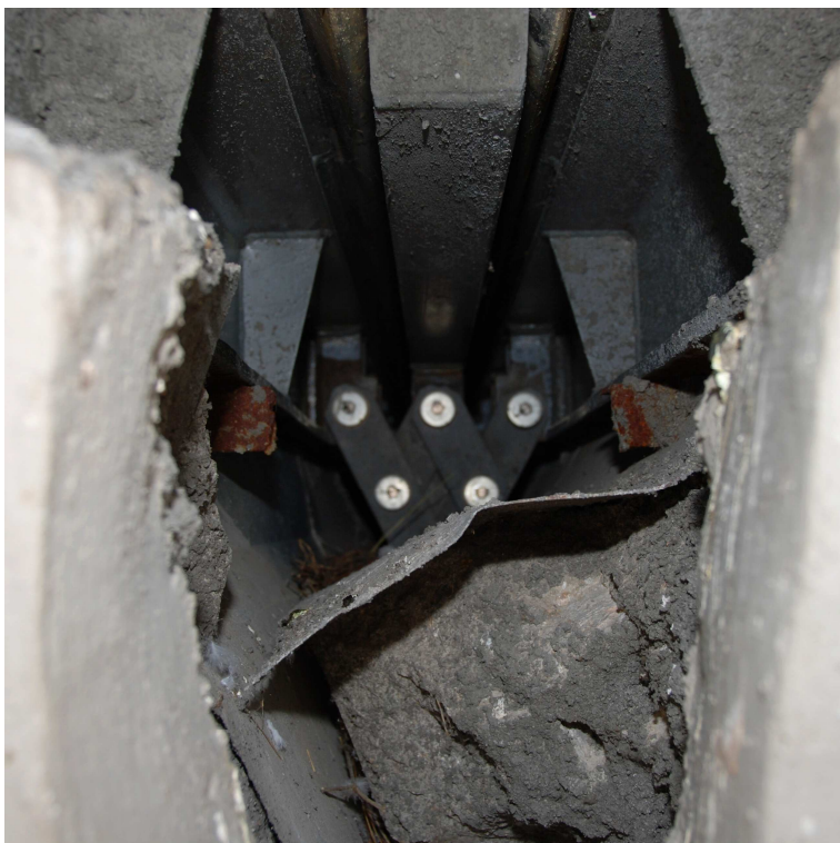
Obrázek 13 Při bližším pohledu vidíme, jak vyhřezlý beton ve skutečnosti znemožňuje správnou funkci dilatačního závěru.
