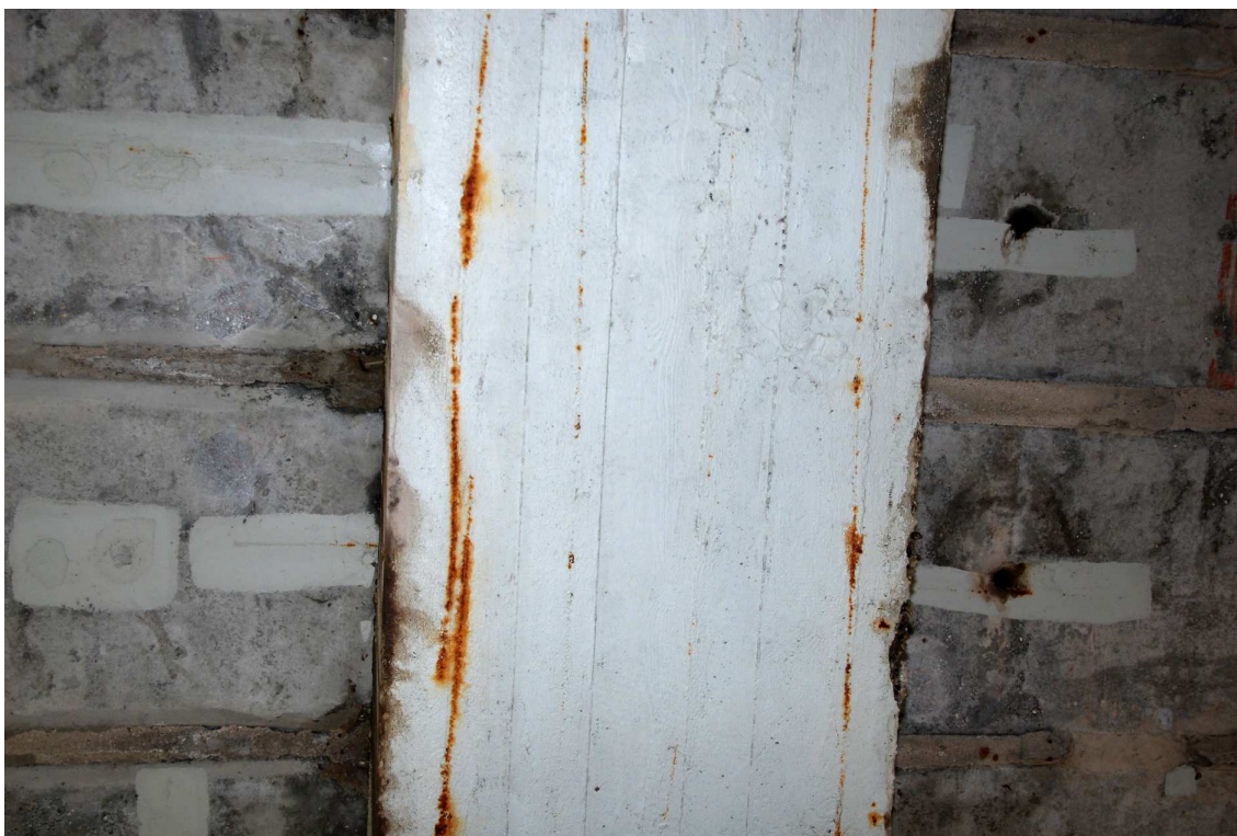
Obrázek 6 Jiný most než na horním obrázku. Pečlivě zasanované odvodňovací otvory nosníků KA.
