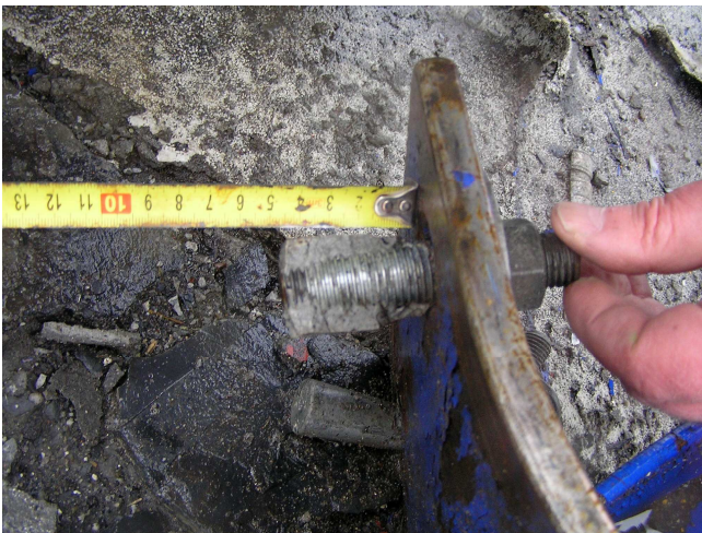
Obrázek 15 Drama se skrývá v detailech... kotvení zábradelních sloupků může vypadat takhle,
