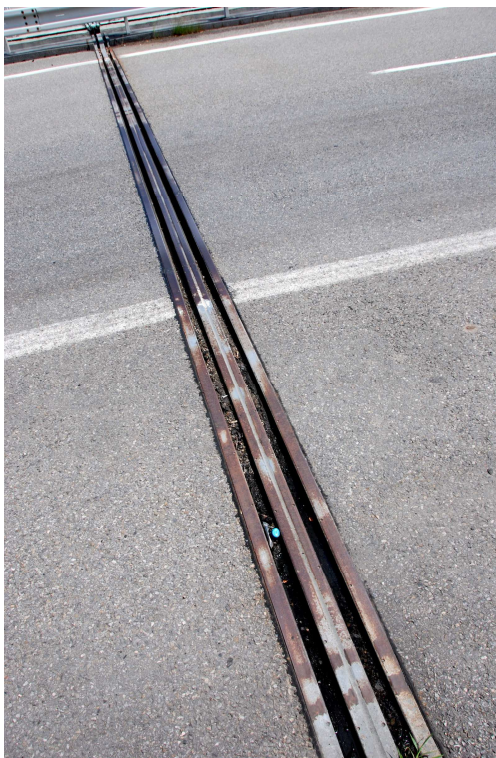
Obrázek 12 Shora jde o bezvadný stav dilatačního závěru.
